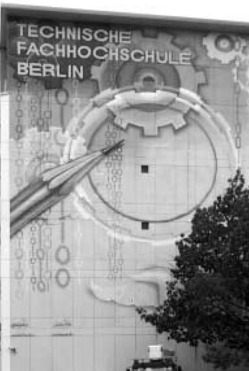
Die Stirnwand »Haus Gauß« in neuem Gewand
